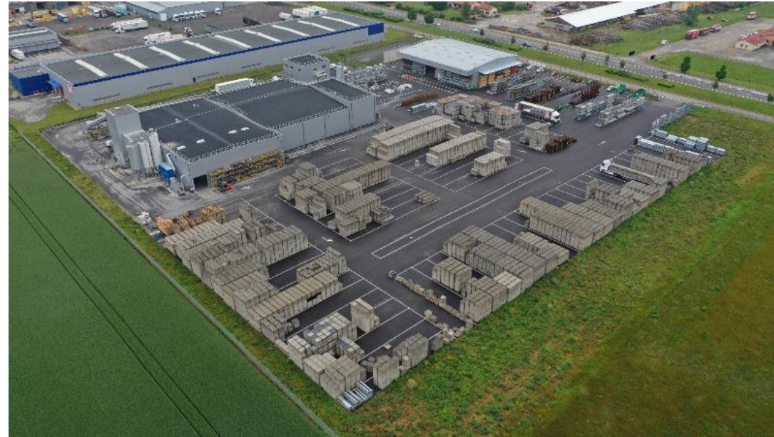
Usine de préfabrication de bloc de béton de Viriville (38)
