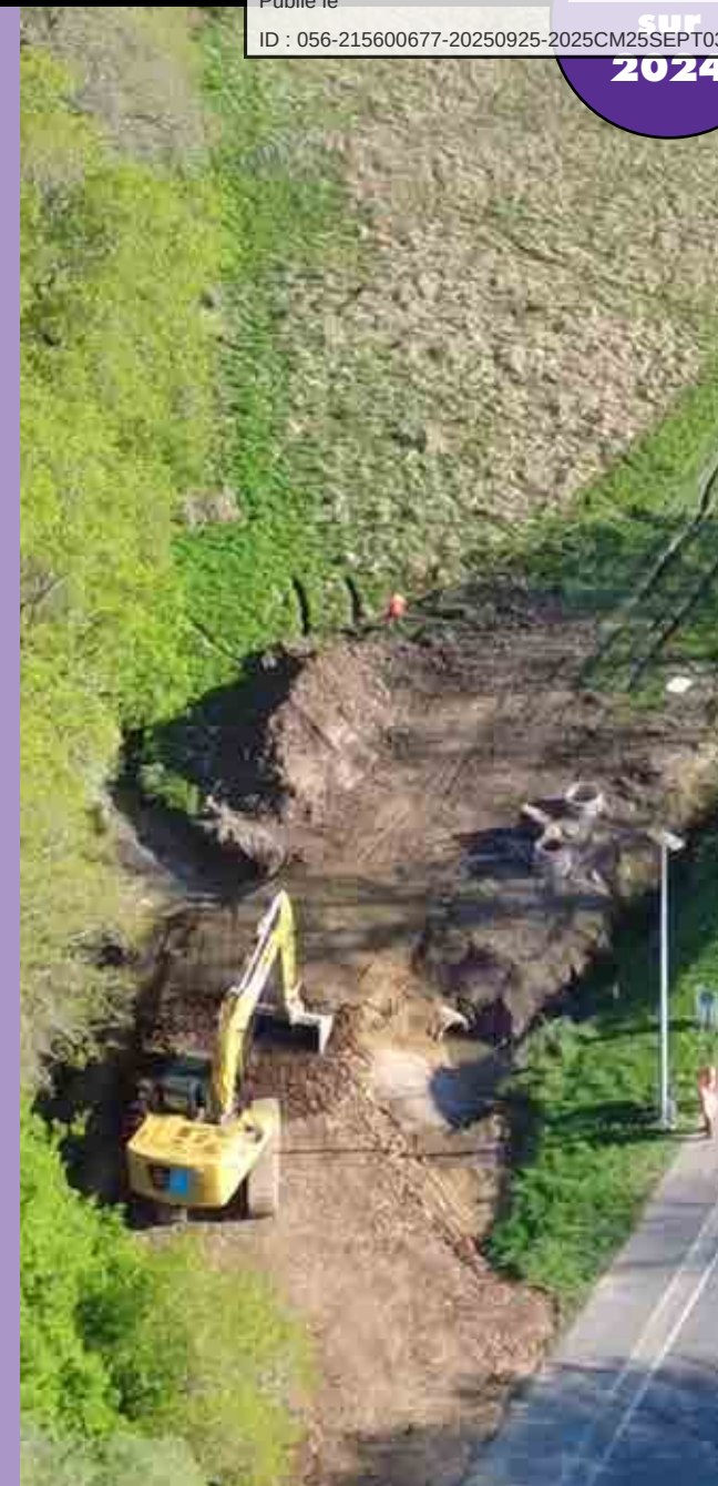
Travaux de restauration des cours d'eau à Saint-Avé.
