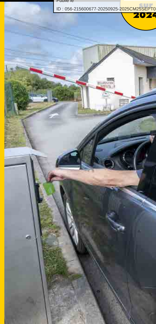
Un contrôle d'accès a été mis en place à la déchèterie d'Arradon
