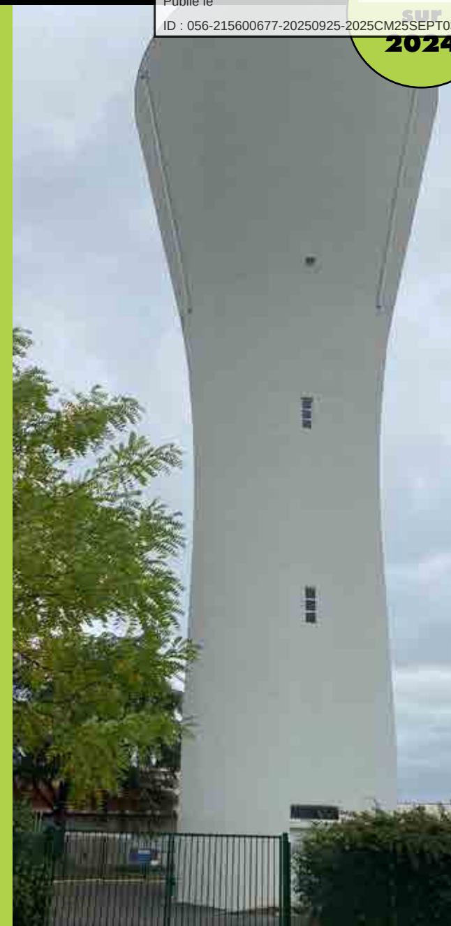
Rénovation du reservoir du Pargo
