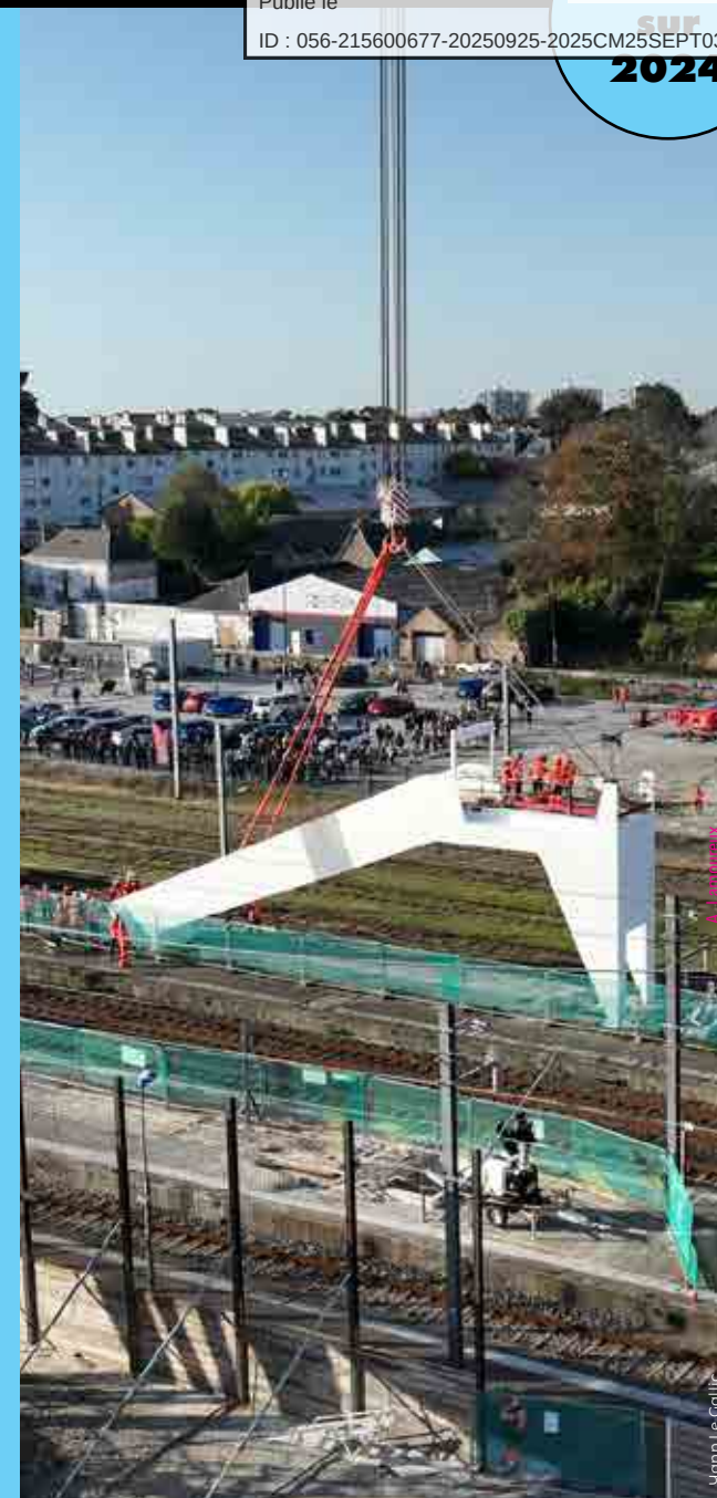
Pose de la passerelle du PEM de la gare de Vannes (novembre)
