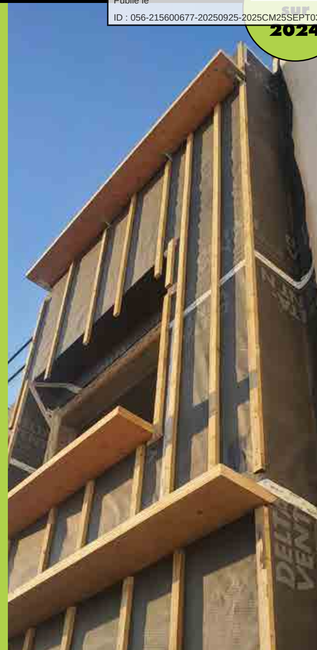
Le Campus DataScience et cybersécurité, un chantier exemplaire avec isolation par l'extérieur, notamment.
