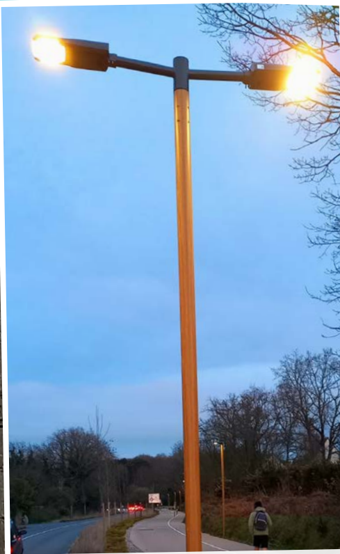
En sobriété à Auray, des mâts éclairent à la fois l'avenue de l'Océan et le nouveau chemin piétonnier réalisé en parallèle pour offrir aux piétons et cyclistes un parcours très sécurisé.
