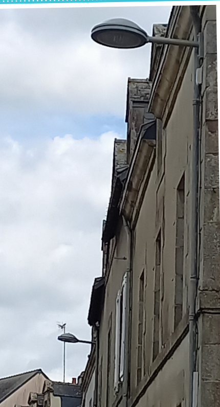
À Questembert, un éclairage en applique et en sobriété, posé rue Alain Le Grand, à l'occasion de travaux de sécurisation de la circulation. Le dispositif libère ainsi de la place sur le trottoir de cette voie étroite, menant au centre-ville.
