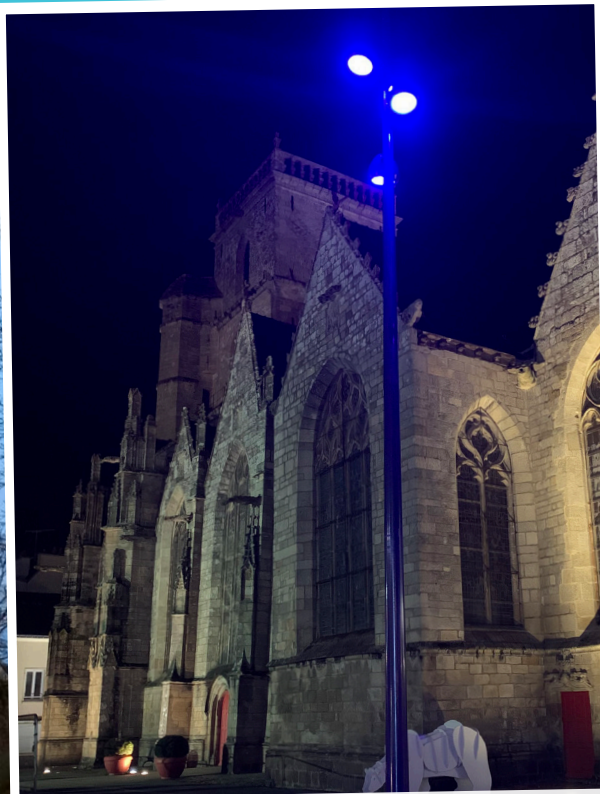
À Ploërmel, l'importante opération de rénovation du centre-ville s'est accompagnée de la mise en place d'un éclairage public dynamique qui permet d'agir sur l'intensité lumineuse et les couleurs.
