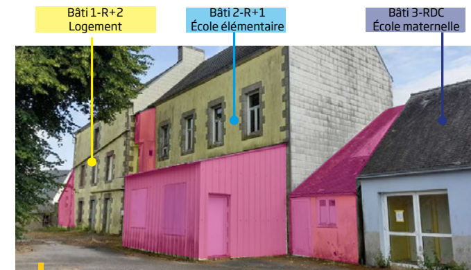
Façade nord avec ses nombreux décrochés et extensions disparates et vétustes
