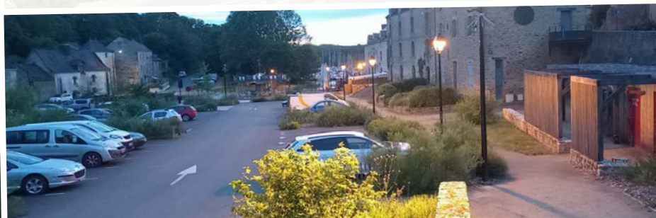
Un réaménagement complet pour le parking de La Voûte à La Roche Bernard où Morbihan Énergies a installé un nouvel éclairage, la vidéo protection, des bornes « marché » et une station de recharge pour véhicules électriques.
