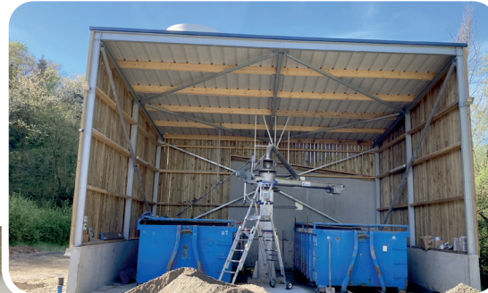
nouvelle unité de déshydratation des boues - Ploërmel
