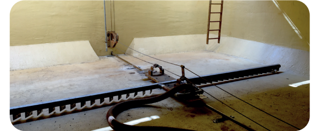
réhabilitation des revêtements - Ploërmel
