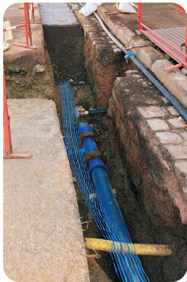
renouvellement des canalisations
