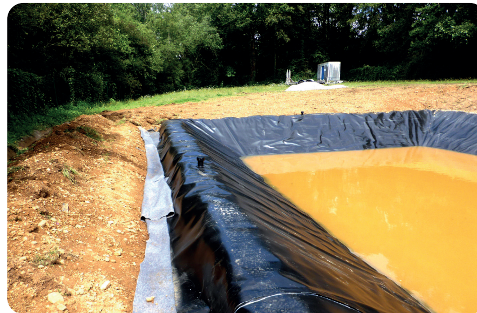
unité de production des Moulins - Rieux
