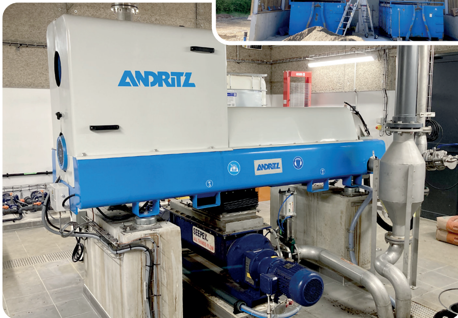
nouvelle unité de déshydratation des boues - Ploërmel
