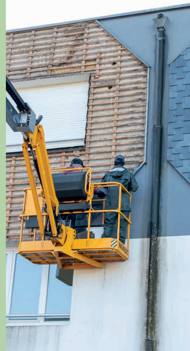
Le chantier Datascience et Cybersécurité : un chantier pilote sur le réemploi.
